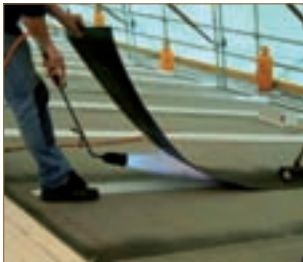
L'étanchéité de toiture
