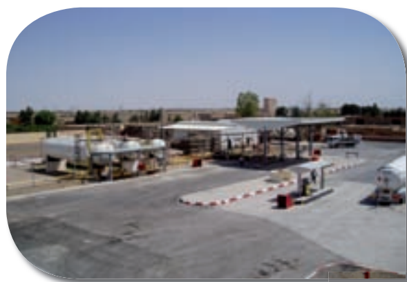
Réalisation d'un centre emplisseur complet, Naftal, M'Sila, Algérie
