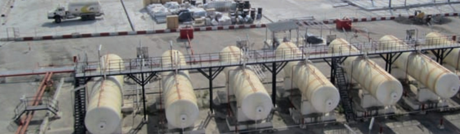
Réalisation d'un centre emplisseur complet Naftal, Béjaia, Algérie
